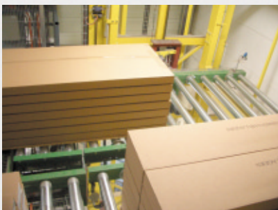
2 Senkrechtförderer zur Beschickung und zur Entsorgung des Lagers.
